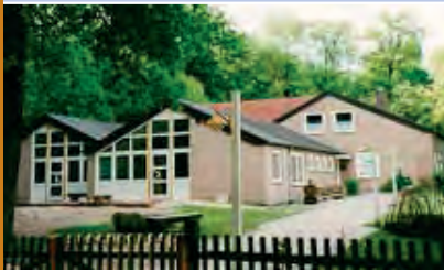
Sanierung Kindergarten in Niedersachsen
