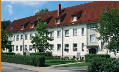
Sanierung Wohnanlage mit 15 Einheiten in Niedersachsen
