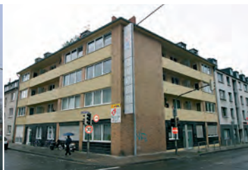
Sanierung Wohnanlage mit 19 Einheiten in Nordrhein-Westfalen
