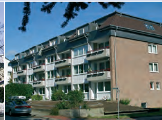
Neubau Wohnanlage mit 35 Einheiten in Niedersachsen
