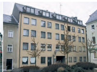
Sanierung Wohnanlage mit 13 Einheiten in Bayern
