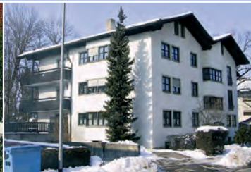
Sanierung Wohnanlage mit 17 Einheiten in Bayern
