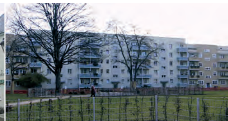
Sanierung Wohnanlage mit 44 Einheiten in Thüringen
