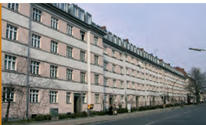
Sanierung Wohnanlage mit 141 Einheiten in Berlin
