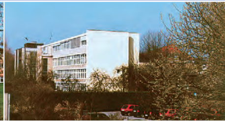
Sanierung Schule in Niedersachsen
