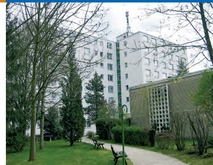
Projektbeispiel Sanierung: Seniorenzentrum in Eschwege
