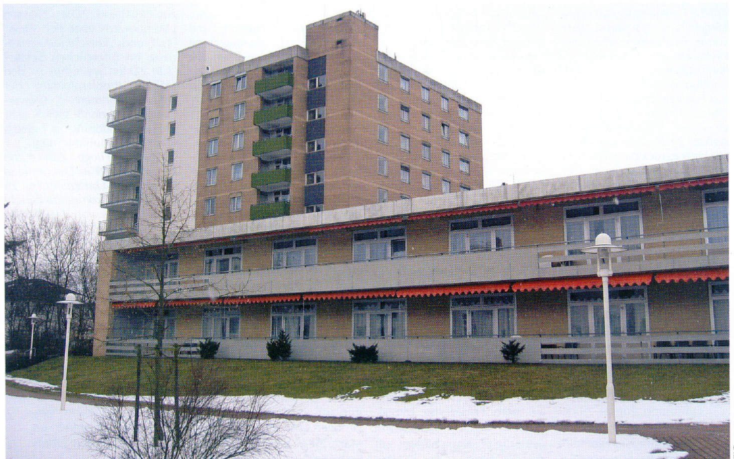
Mit einer neuen Heizstation und modernster Technik sparen die Betreiber dieses Seniorenheims im Nordhessischen bares Geld, das sie an anderer Stelle investieren können.
